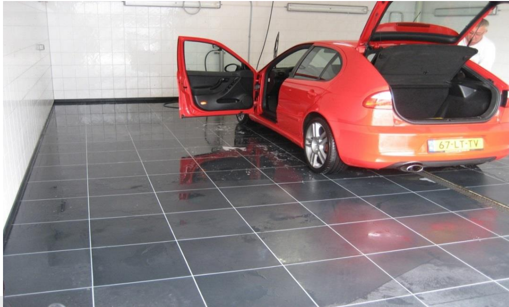
Foto: Vloer uitgevoerd met kunststof elementen.
