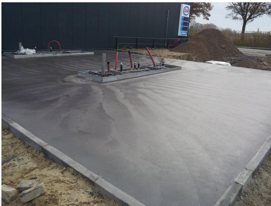
Foto: Aanleg van vloeistofdichte betonvloer.
