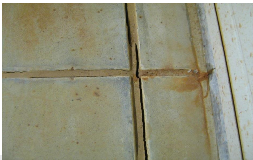
Foto: Beschadigde kitvoeg.
