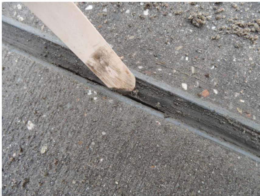
Foto: Afdichting is onthecht.
