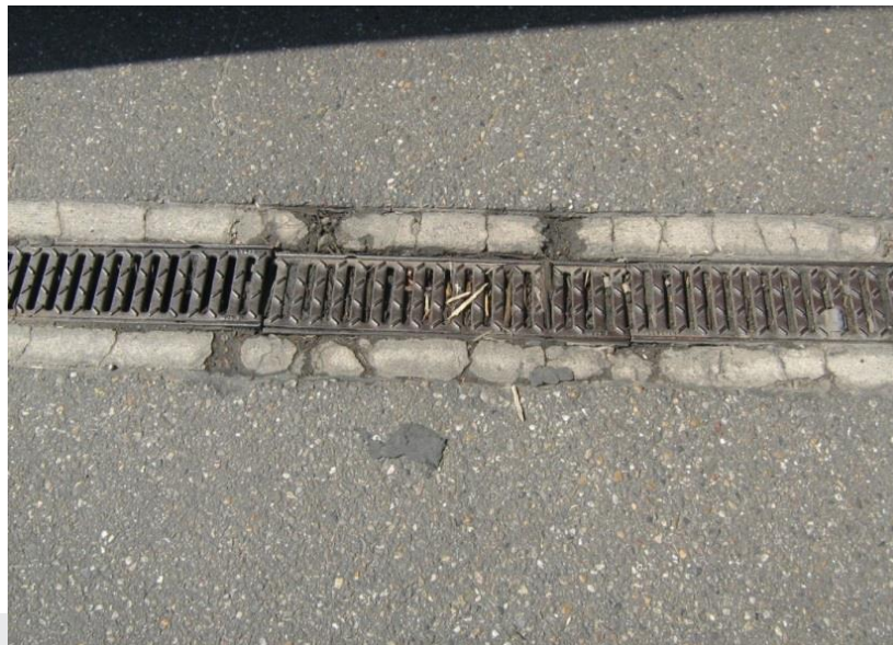
Foto: Aansluiting met lijngoot die niet vloeistofdicht is afgewerkt.
